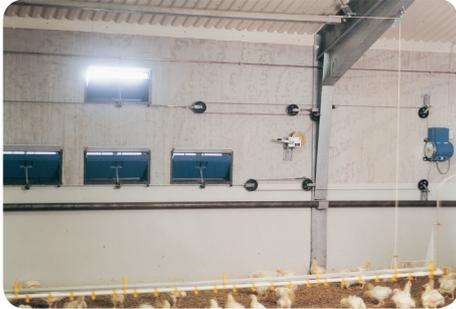
Sowohl DA 1200/1211/1911 als auch DA 1500 sind mit differenzierter Öffnung erhältlich, was die Effektivität der einströmenden Luft besonders im Winter verbessert. Bei einem geringen Luftbedarf ist z. B. nur jedes vierte Ventil offen. Dadurch wird die Luft in wenigen, aber kräftigen Strahlen gesammelt. Dies schafft die besten Bedingungen im Stall. SKOV hält ein Patent auf die differenzierte Öffnung.
