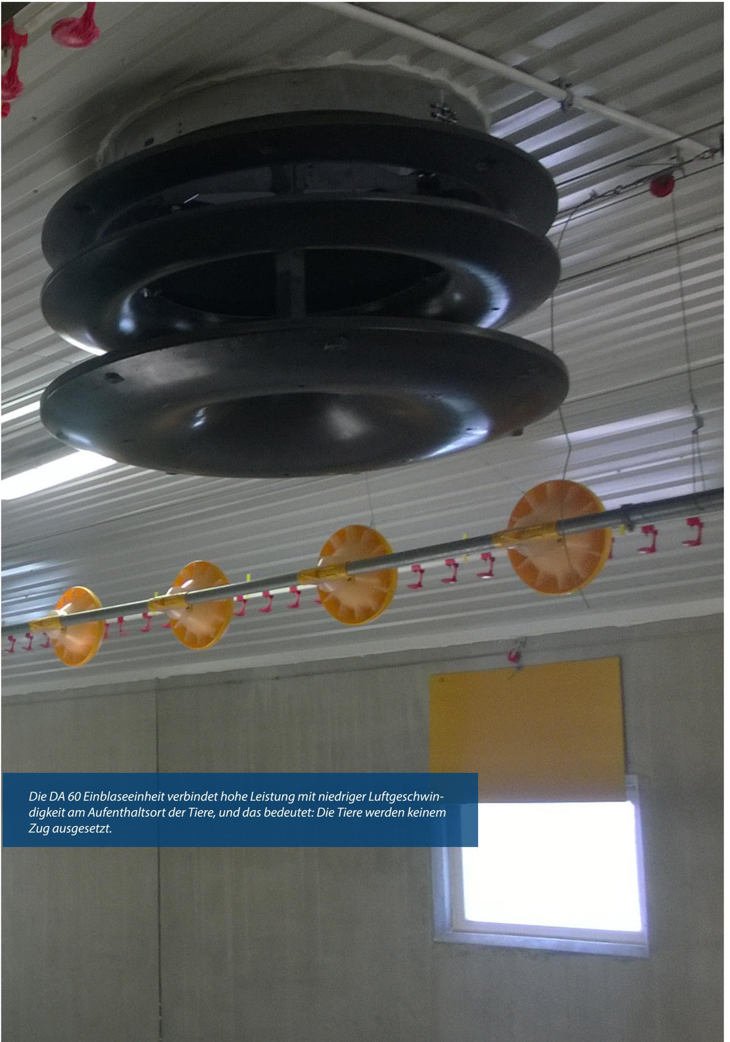
*Die DA 60 Einblaseeinheit verbindet hohe Leistung mit niedriger Luftgeschwindigkeit am Aufenthaltsort der Tiere, und das bedeutet: Die Tiere werden keinem Zug ausgesetzt.*
