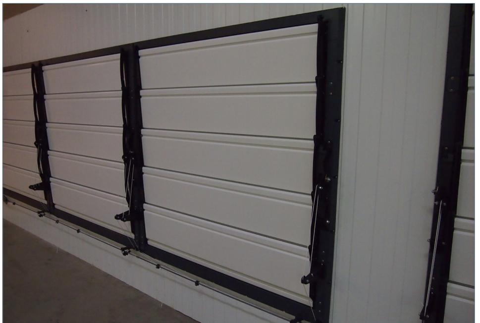
*Die gedämmten Ventilklappen der DA 17K Tunnel-Ventile verhindern kalte Bereiche vor dem Ventil und sorgen dafür, dass die Tiere optimale Bedingungen erhalten.*
