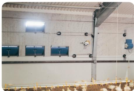
Les clapets DA 1200/1211/1911 et DA 1500 sont construits avec un système d'ouverture différenciée qui accroît l'efficacité de l'air admis, surtout en hiver. Par exemple, seul un clapet sur quatre s'ouvre quand le besoin d'air est réduit. Les filets d'air sont ainsi concentrés et puissants, ce qui assure une ventilation idéale. Ce système d'ouverture différenciée est breveté SKOV.
